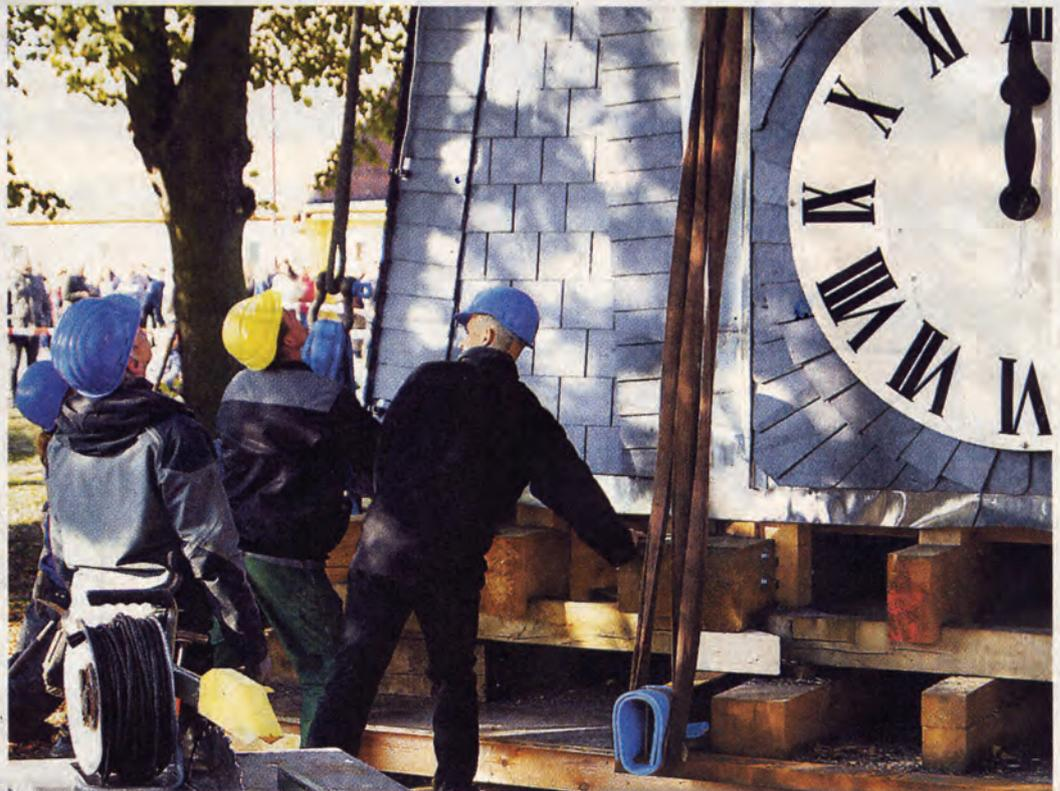
Alles bereit? Die am Boden gefertigte 20 Meter hohe und 29 Tonnen schwere Kirchturmspitze wurde per Kran auf den Turmstumpf gehievt. foto: fs
